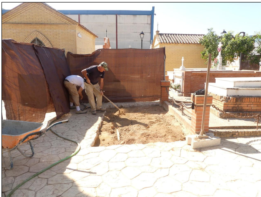
Sondeo 1. Una vez terminado la excavación del sondeo se ha cubierto con la tierra extraída.
